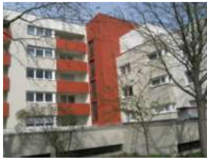
...und nach der Renovierung
